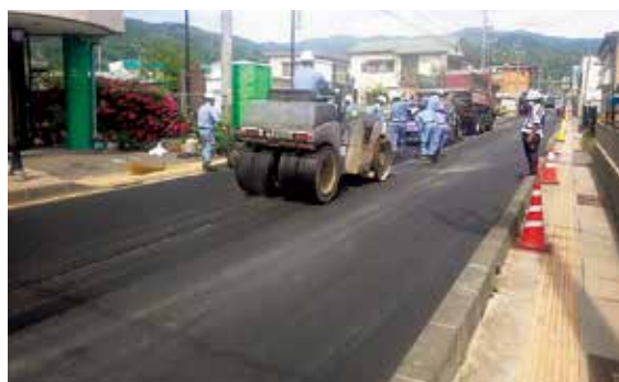
道路維持補修工事
