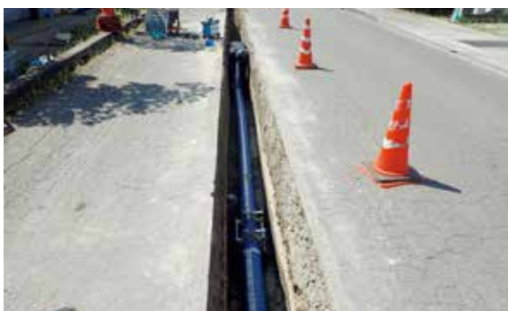
上水道 配水管布設替工事
