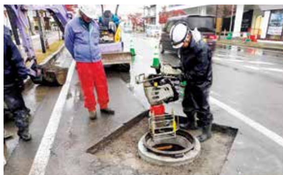
下水道 鉄蓋交換工事
